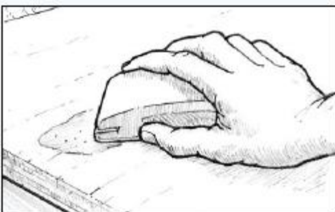
Рис. 23. Шлифуйте застывший материал, чтобы добиться необходимого результата
